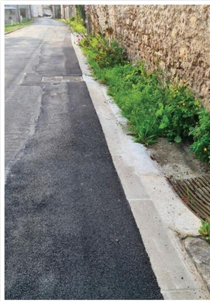
Une réfection de la bordure et du caniveau a été engagée pour rétablir l'écoulement vers le ru.
