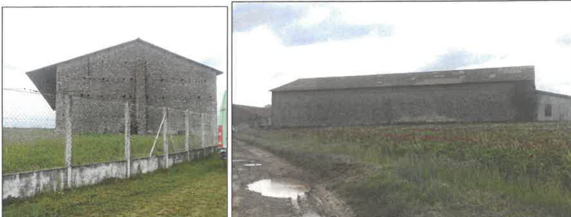
Bâtiment agricole existant au sud-ouest de la ferme de La Brosse : pignon nord (largeur : 15,5 m) et façade ouest (longueur : 41 m)
