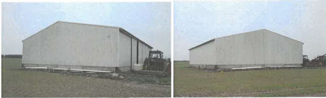
Exemple 4 : hangar de 29,3 mètres par 16,4 mètres (Tousson)
