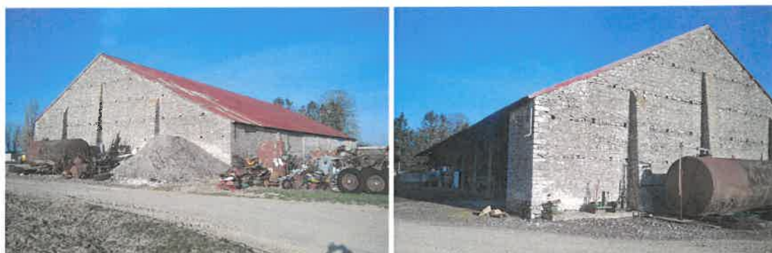
Hangar de 47 mètres par 25 mètres (Tousson)
