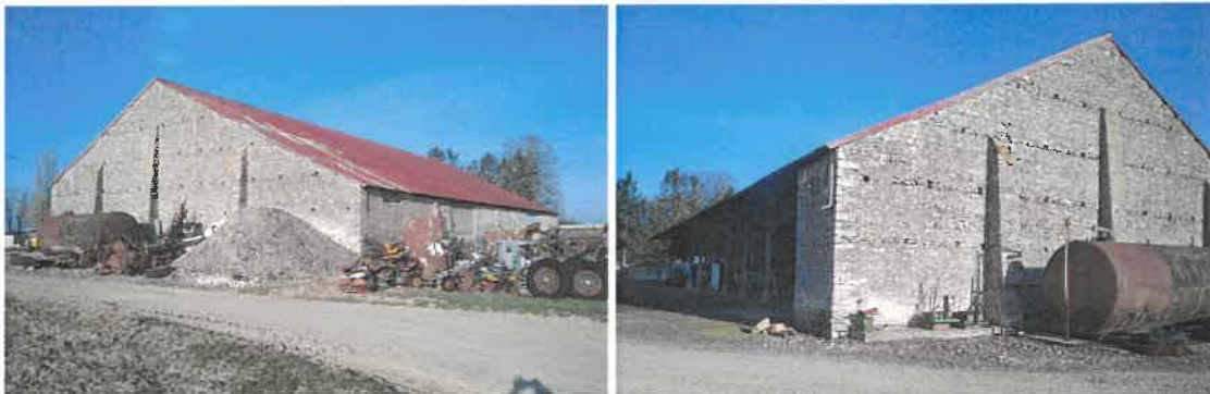
Exemple 5 : hangar de 47 mètres par 25 mètres (Tousson)
